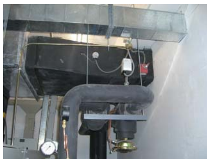
(c) 送风管道内静压传感器的安装
